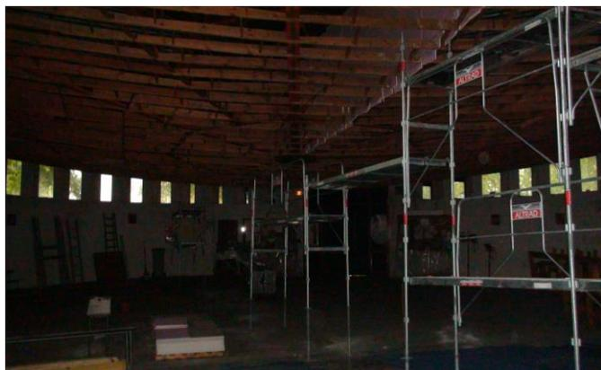
*Plafond en rénovation : l'ancienne frisette en pin a été retirée. Les poutres en bois sous-jacentes apparaissent.*
